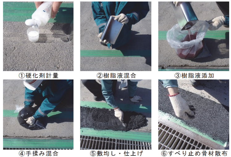
写真-3 開発品の施工手順
