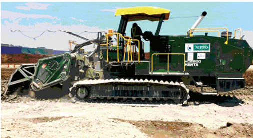
写真-1 ディープスタビライザによる路床改良施工状況
