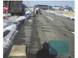
写真-4 施工箇所
