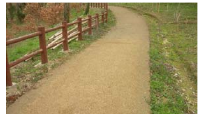
写真-1 施工後の舗装体の様子
