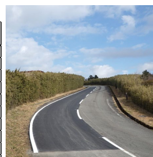
写真-3 試験舗装完成状況
