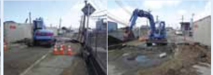
鹿嶋市の市道における応急復旧の様子
