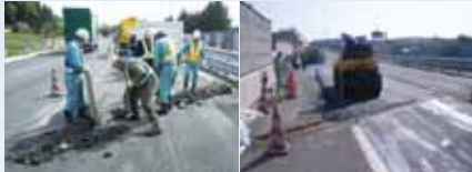
高速道路路面の応急復旧工事の様子
