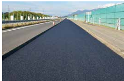
施工後の様子(上信越自動車道)
