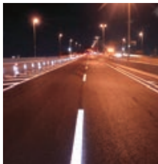
舗装補修大規模修繕工事 (30-7-湾)
