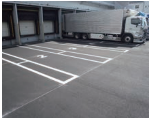
「ハードアスコン」の施工後の様子
