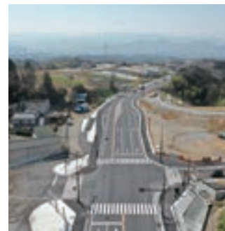
平成30年度 1号笹原山中BP笹原新田地区西舗装工事
