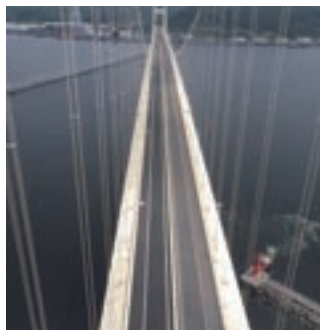
一般国道37号 室蘭市白鳥大橋舗装補修工事
