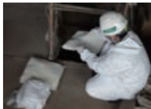
特殊なエポキシ樹脂を投入
