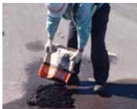
雨天時や湿潤状態でも舗装補修可能
