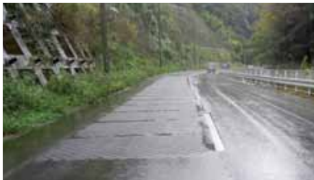
福井県内での施工例（左側車線）
