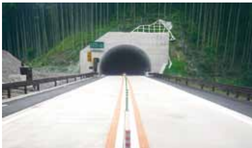
● 国土交通省 近畿地方整備局 近畿自動車道紀勢線 見老津第二トンネル コンクリート舗装工事 【和歌山県】
