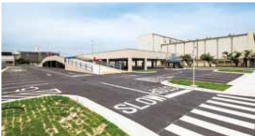
● 防衛省 中国四国防衛局 岩国飛行場 (H25) 立体駐車場 (集会施設) 新設建築その他工事 【山口県】
