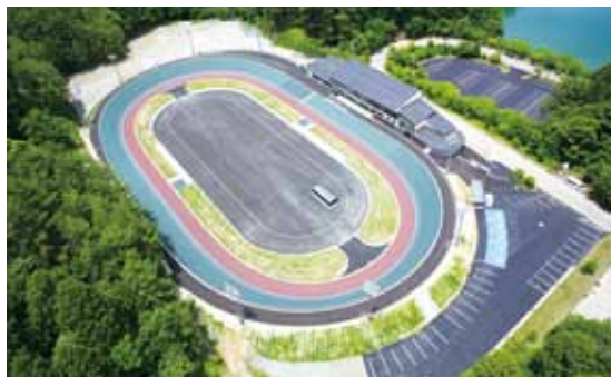
● 松本市 (仮称) 松本市美鈴湖 自転車競技場建設工事 【長野県】
