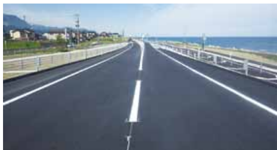
● 国土交通省 北陸地方整備局 大和川・押上道路工事 【新潟県】
