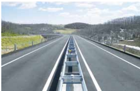
● 国土交通省北海道開発局 一般国道 274 号 標茶町沼幌中央帯設置工事 【北海道】
