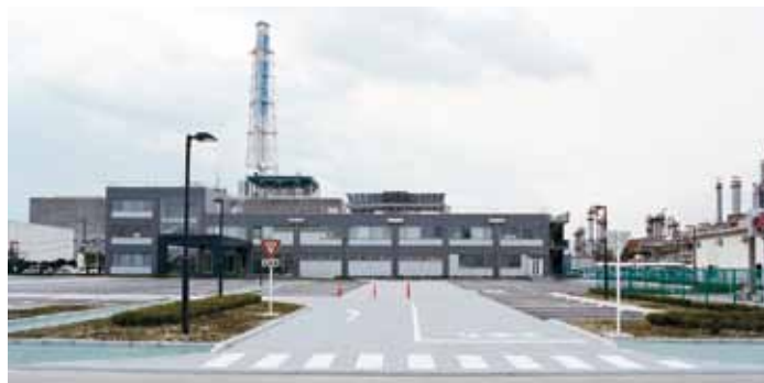
● JX日鉱日石エネルギー株式会社 仙台製油所 本館事務所建設工事（建築工事） 【宮城県】
