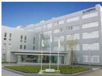
総合技術センター 建物全景
