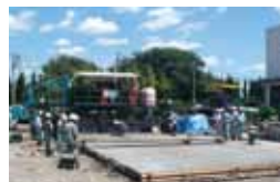
屋外試験場での試験施工状況
