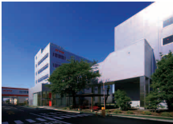
● KYB株式会社 相模工場新棟建設工事 【神奈川県】
