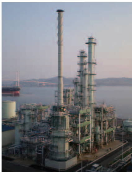
● 新日本石油精製株式会社 室蘭製油所 キュメン装置建設工事 【北海道】
