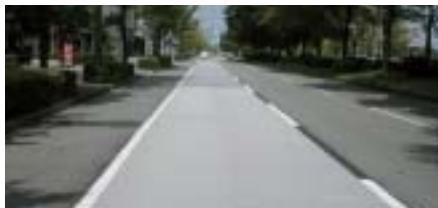
「パーフェクトクールEM」の車道への適用例
