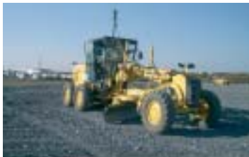
民間大型駐車場工事（路盤工）
