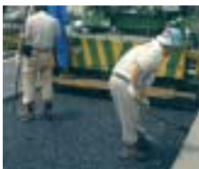
ポーラス(20)の舗設
