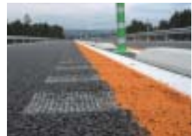
暫定2車線の高速道路での施工例
