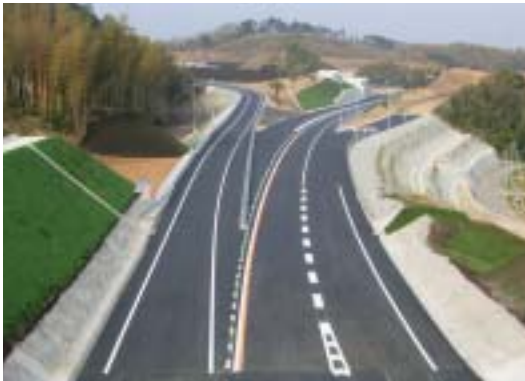
● 宮崎10号 延岡JCT舗装工事 【宮崎県】
