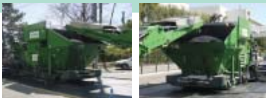
日本での施工状況
