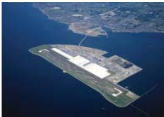
● 中部国際空港滑走路・ 誘導路舗装工事 【愛知県】
