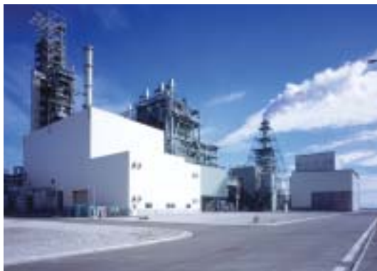
● 室蘭BTG設備 新設工事 【北海道】
