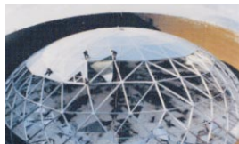
屋根パネルの組立
