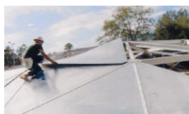
屋根パネルの組立
