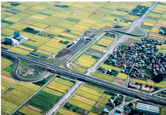
● 東北中央自動車道山形南 舗装工事 【山形県】
