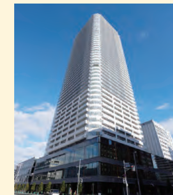
ONE札幌ステーションタワー
