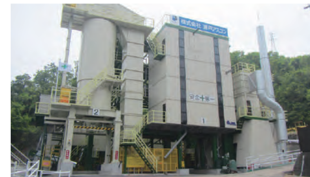
高松合材工場：都市型で環境対策に配慮された工場
