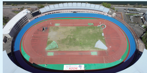
高知競輪場走路改修工事 発注者：高知市
