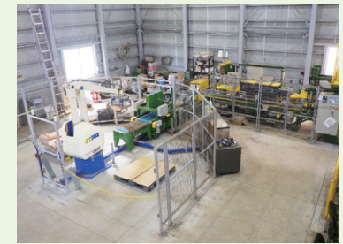
帯広合材工場(常温合材袋詰装置)
