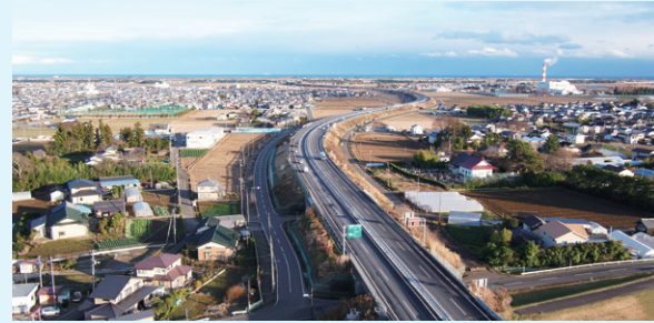
仙台南部道路 長町舗装工事 発注者：東日本高速道路(株) 東北支社
