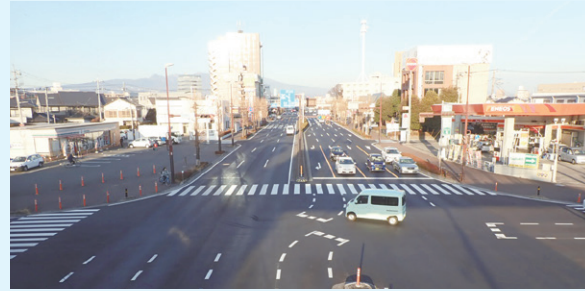
R3・R4国道17号鳥羽地区外電線共同溝工事 発注者：国土交通省 関東地方整備局
