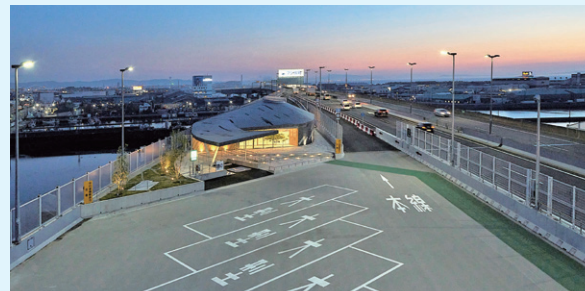
舗装および高欄設置その他工事(2019-大管) 発注者：阪神高速道路(株)
