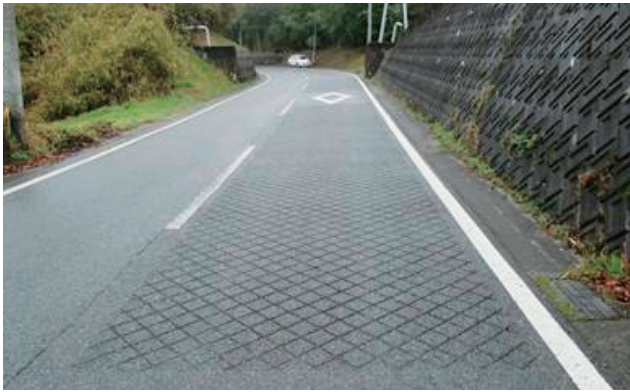
グリップサーフの施工事例(既設・ラティス(全面型))
