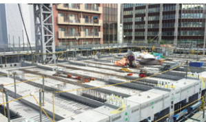
PC床版施工事例
