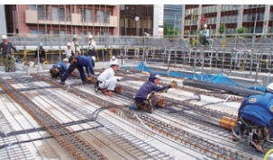
鉄筋ロールマット工法事例
