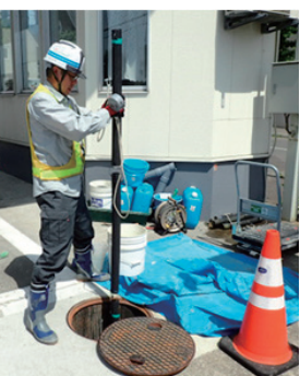
材料を入れた有孔管。酸素発生剤は水に触れると酸素を発生します。
