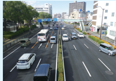
工事名：令和2-3年度徳島出張所管内舗装修繕工事 発注者：国土交通省四国地方整備局
