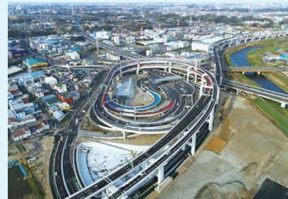
工事名：高速横浜環状北西線他舗装他工事 発注者：首都高速道路(株)
