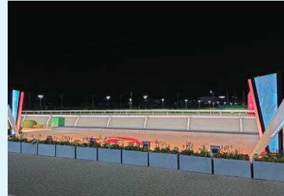
工事名：大井競馬場 本馬場入場路および馬通路拡張その他工事 発注者：東京都競馬(株)
