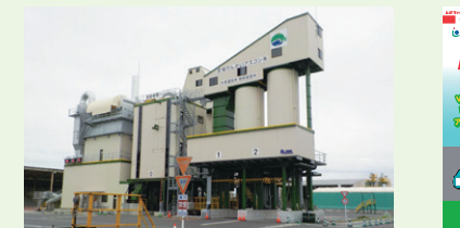
多賀城合材工場
