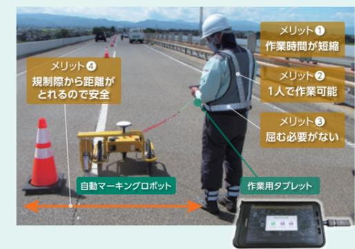
自動マーキングロボットによる通り出し作業：人員・時間が大幅に削減可能に。作業者の負担も軽減。
