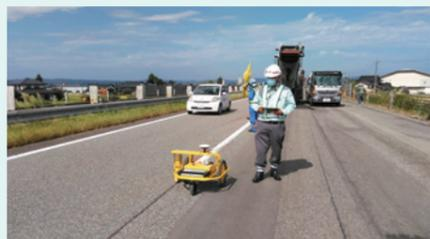
マーキングロボットによる機械化
