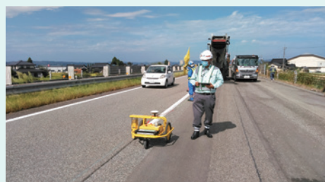
マーキングロボットによる機械化
