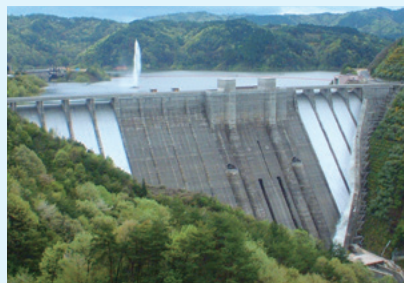
小里川ダム本体建設工事
