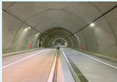
国道106号川井地区舗装工事
