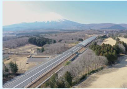
令和2年度 国道138号バイパス須走南水士野北地区舗装工事
