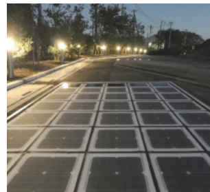
太陽光発電舗装
