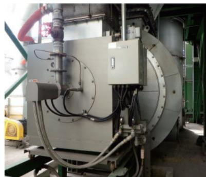
横浜合材工場：環境対策として、高効率バーナ(脱臭炉付き)に更新
