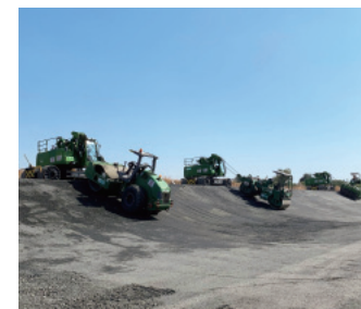
海外テストコースのバンク舗装工事
