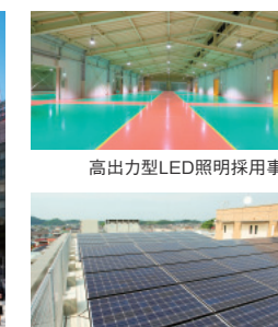
高出力型LED照明採用事例
