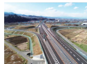
東北中央自動車道 上山舗装工事
