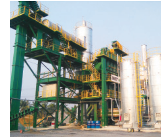
タイのグループ会社 再生アスファルトプラント
