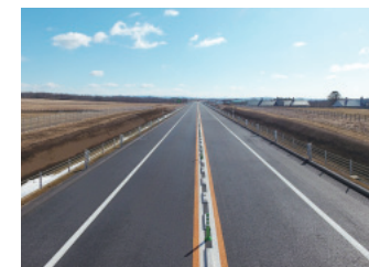
日高自動車道（日高町） 2018年3月竣工
