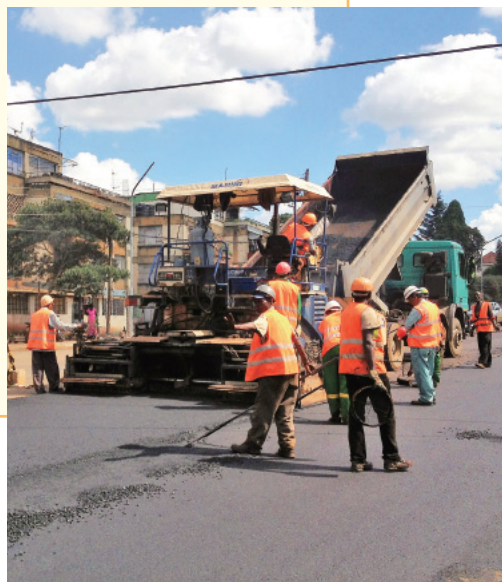
ケニア、ナイロビ舗装工事
