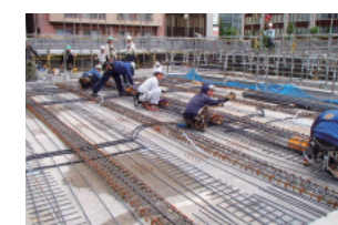
鉄筋ロールマット工法事例
