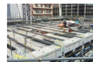
床PC版施工事例
