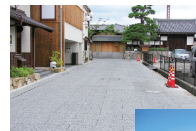
半たわみ性舗装「テラゾーポリシール」
