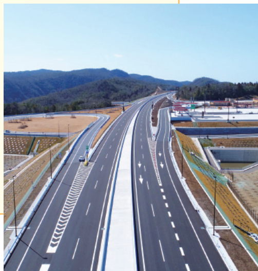
新名神高速道路神戸舗装工事
