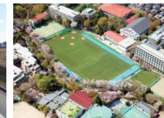
グラウンド整備工事 2018年3月竣工
