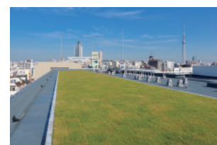
ル・サンク東京森下(屋上緑化設置状況)
