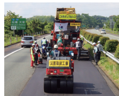
熊本地震の復旧工事の様子
