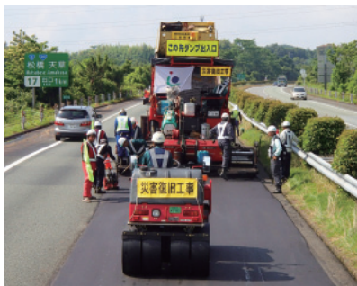
熊本地震の復旧工事の様子
