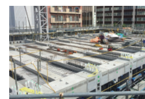
床PC版施工事例
