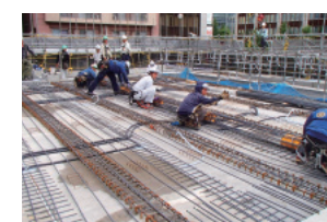
鉄筋ロールマット工法事例
