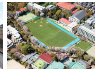
グラウンド整備工事 2018年3月竣工
