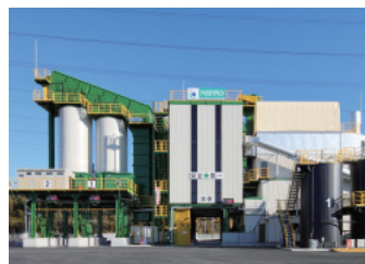
筑波合材工場
