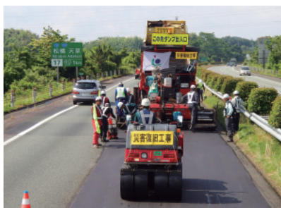
熊本地震後の復旧作業の様子
