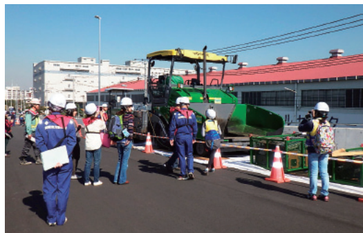
工事現場見学会の様子
