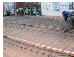
壁鉄筋先組工法事例
