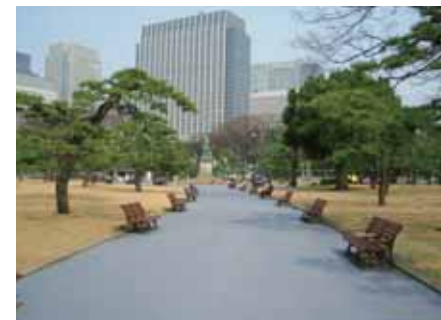
皇居前広場の遮熱性舗装（パーフェクトール）
