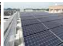
屋上太陽光発電設置事例
