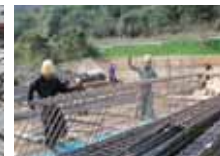
鉄筋蛇腹ユニット工法事例
