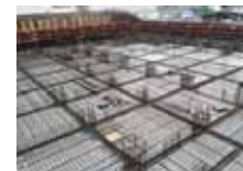
PC版合成床施工事例
