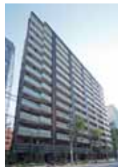
マンション建築
