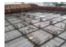
PC版合成床施工事例
