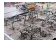
マイクロバブルオゾンスパージング施工状況
