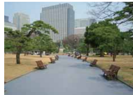
皇居前広場の遮熱性舗装（バーフェクトール）
