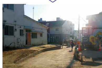
土砂片付け後
