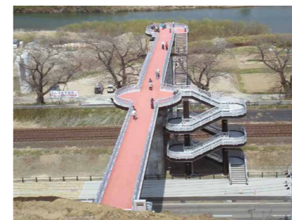
さくら連絡橋
