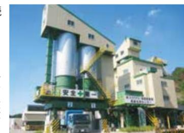
プラントを全閉型のシェルタータイプとし、都市ガスを燃料とし且つ脱臭炉を導入するなど2013年度に環境整備を図った例(岡崎合材工場)
