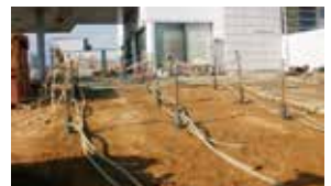
原位置工法による施工状況の一例
