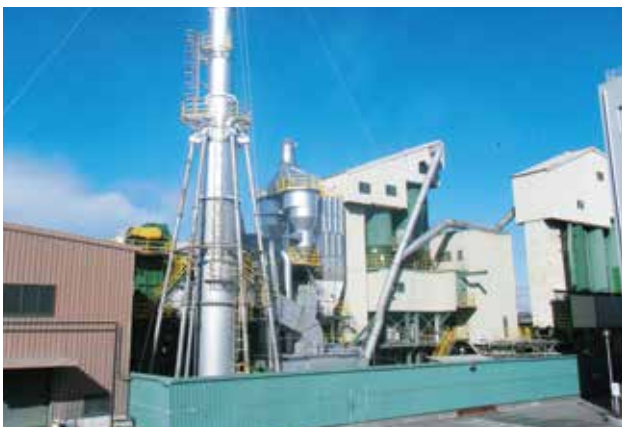
プラントを全閉型のシェルタータイプとし、都市ガスを燃料としかつ脱臭炉を導入するなど、2012年度に環境整備を図ったさいたま合材工場
