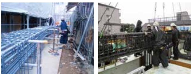
鉄筋地組み工法事例
