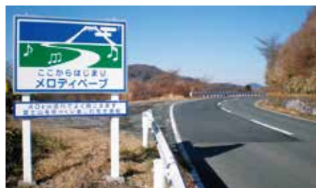
メロディペーブ 施工状況
