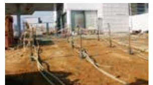
原位置工法による施工状況の一例
