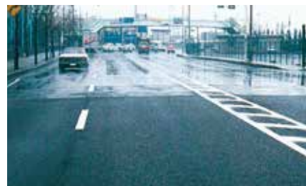
雨天での供用状況 (手前：パビーアス、 奥：一般的な舗装)
