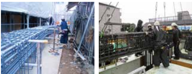
鉄筋地組み工法事例
