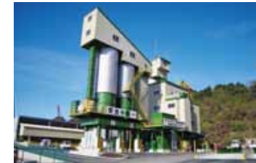
プラントを全閉型のシェルタータイプとし、都市ガスを燃料とする設備を導入し、2011年度に環境整備を図った例:岡崎合材工場
