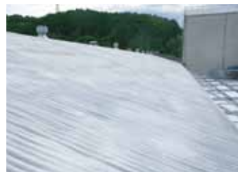
屋根断熱防水施工後状況
