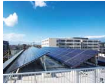
屋上太陽光発電設置事例
