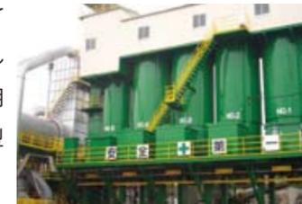
合材サイロを全閉型のシェルタータイプとし、環境整備を図った大和合材工場
