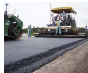
CO 2 排出量を削減する低炭素舗装（第二東名高速道路）
