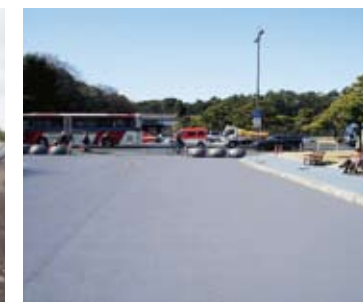
ヒートアイランド現象を抑制する舗装（皇居外苑前桜田門）
