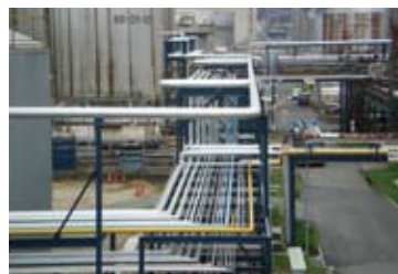
配管施設状況
