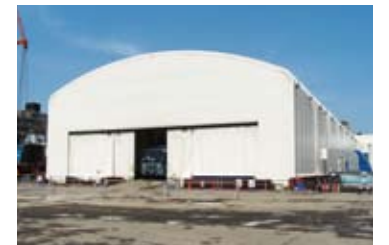
土壌浄化テント
