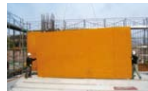
大版型枠工法
