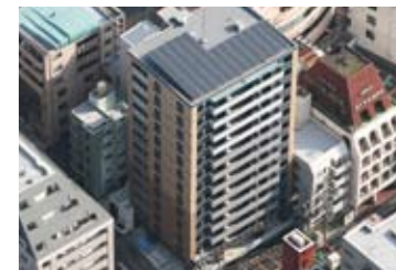
太陽光発電を搭載した長崎・筑後町マンション
