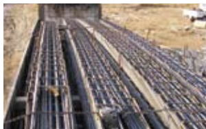
梁筋積載状況
