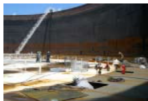
原油タンクの浮き屋根の耐震改修工事
