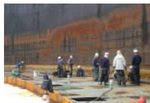
原油タンクの浮き屋根の耐震改修工事
